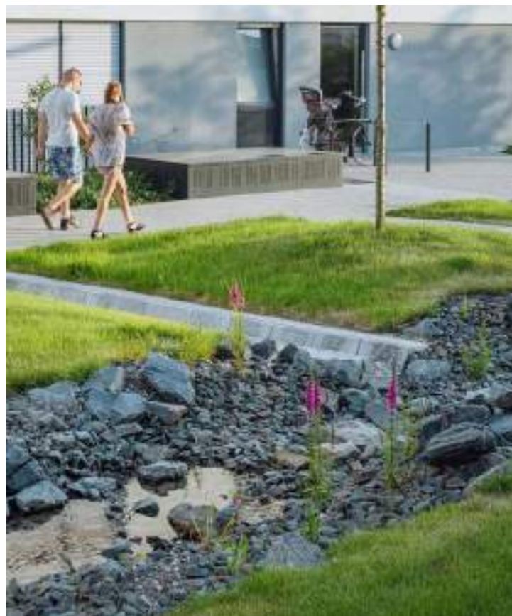
OTWARTE KANAŁY DOPROWADZAJĄCE WODĘ DO OTWARTYCH ZBIORNIKÓW -ELEMENT EDUKACYJNY, KONTAKT Z PŁYNAĆĄ WODĄ
